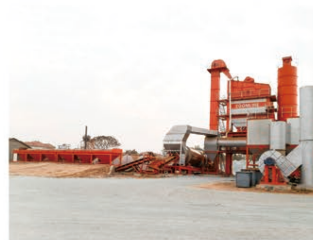
ZAP-S320 Асфальтовый завод в Камбодже
