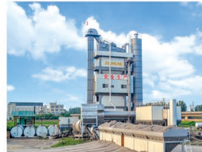
ZAP-S320 Асфальтовый завод в аэропорту Чжэнчжоу
